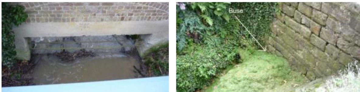
**Figure 6 :** Exemples d'observations faites sur le terrain pour le risque de débordement (passage trop étroit et grillagé et buse bouchée) [Source : IMS<sup>RN</sup>]
