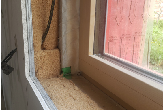
➤ Travaux d'amélioration énergétique du logement
