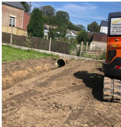
En partenariat avec le SIABOA, la commune a souhaité remettre à ciel ouvert une partie du ruisseau des Anorelles. Les drains vétustes ont été retirés et un rééquilibrage du ruisseau a été effectué. L'objectif, au delà d'être écologique, est de permettre aux habitants de se réapproprier le cours d'eau et de réduire les problèmes d'inondation liés à la saturation du tronçon couvert.
