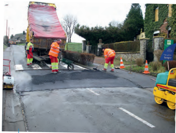
Rue du Revin - Création d'un passage surélevé à proximité de l'école les P'tits Loups Février 2020
