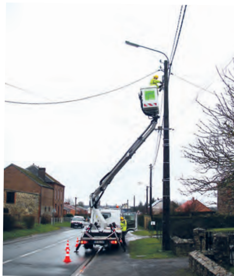
Eclairage public - Installation de LEDS sur les axes traversants (1 ère phase) Mars-avril 2020
