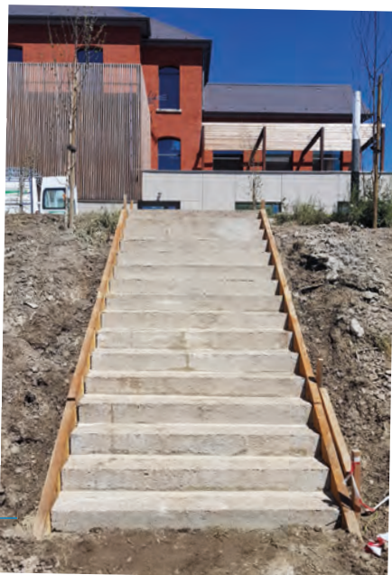
Le « 36 » Un escalier en béton désactivé pour accéder à l'espace de jeux extérieurs Mai 2020
