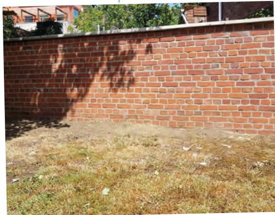
Le « 36 » - Construction d'un mur d'enceinte du nouvel espace de jeux extérieurs Mai-juin 2020
